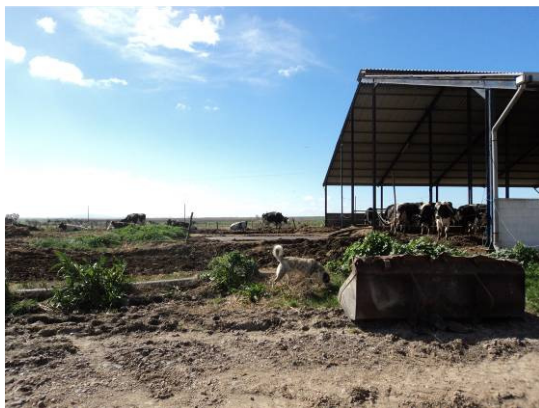
Foto VI.7 – Pormenor da zona da área edificada
